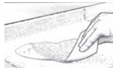
Figure 24 Étalez l'époxyde sur la surface du tissu à l'aide d'un étaleur plastique.
