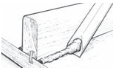
Figure 12 Éliminez ou moulez l'excédent d'époxyde qui coule des joints.
