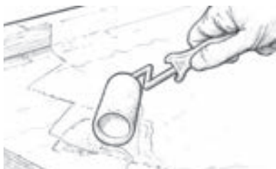
Figure 21 Mouillez les surfaces poreuse avant d'appliquer le composant de profilage.
