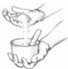
Figure 5 Mélangez des petites poignées d'enduit jusqu'à ce que vous atteignez la consistance souhaitée.
